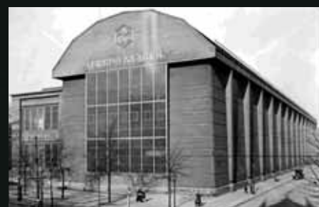
Az 1909-ben épült berlini turbinagyár az ipari építészet egyik meghatározó példája. Forradalmi dizájnját jól példázzák a mindkét oldalon megtalálható, 100 m hosszú és 15 m magas acél-üveg falak. Elsőként itt alkalmazták ezt a merész megoldást, mely tartósan befolyásolta a következő időszak építészeti irányzatait.
